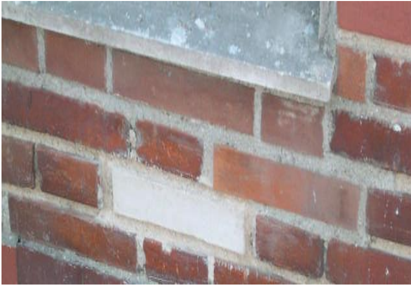
Reparación de huecos
