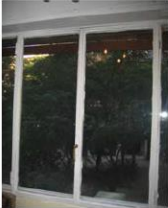
Ventana años 60 Metálica Vidrio monolítico
