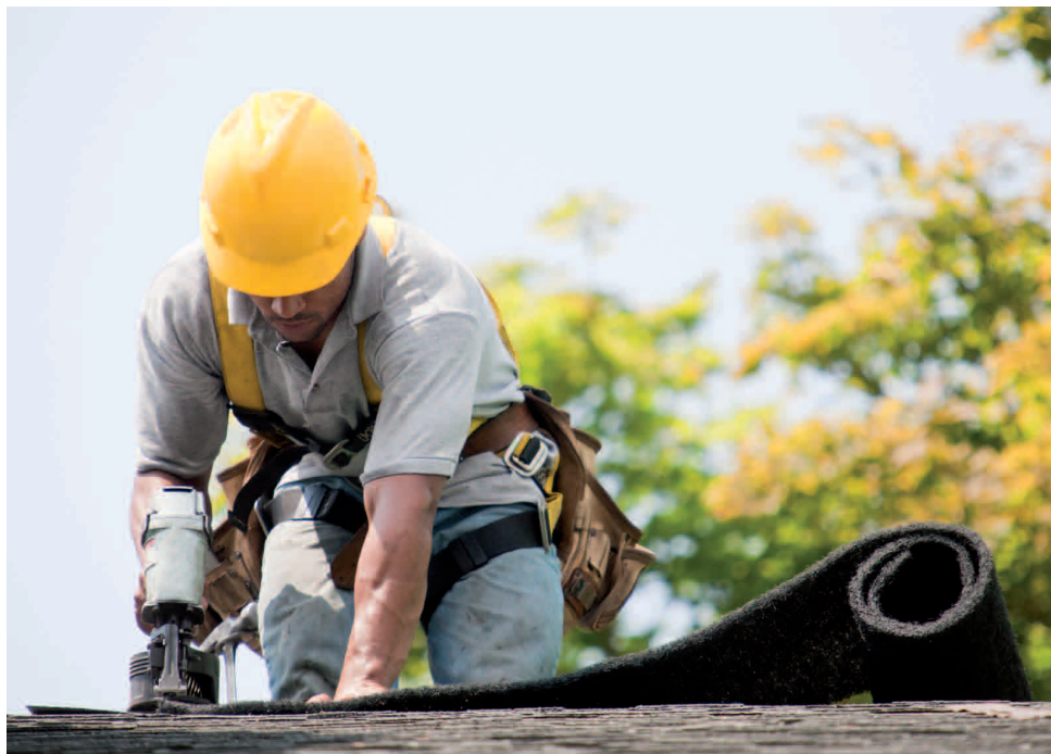
Trabajador realizando trabajos de impermeabilización
