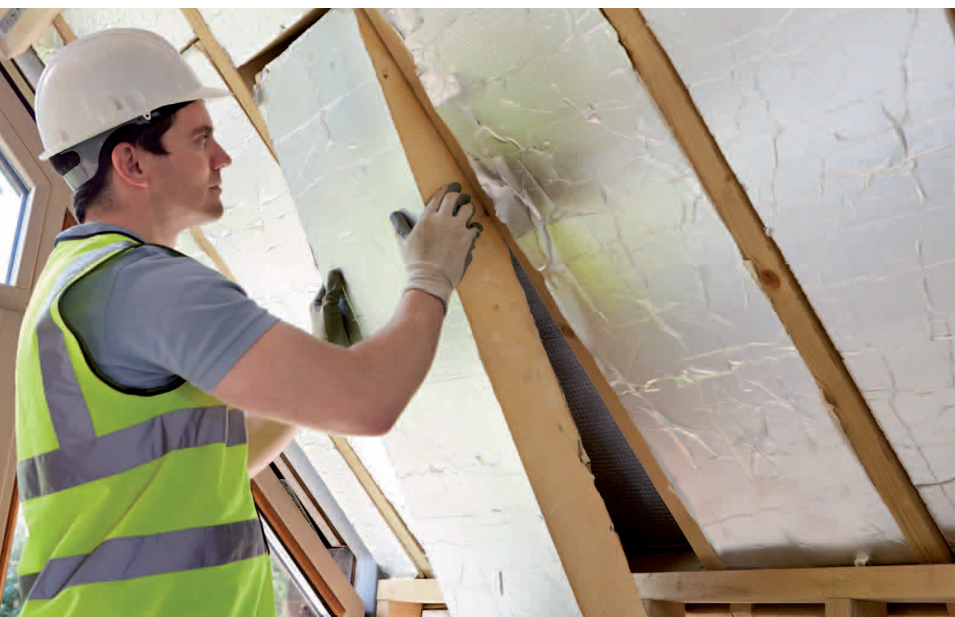
Trabajador realizando tareas de aislamiento
