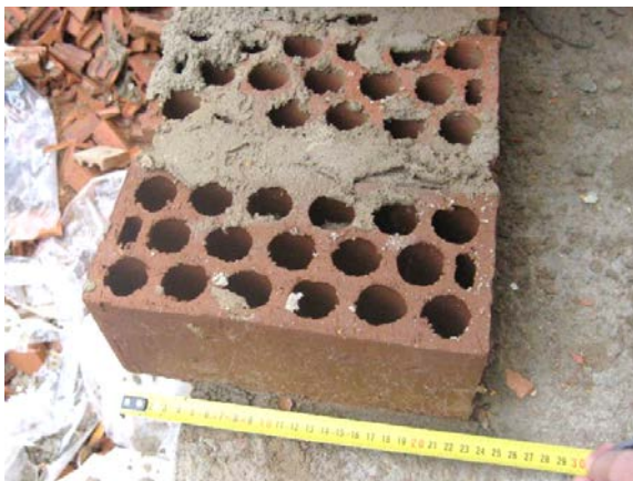
Foto E – Hilada de arranque de fábrica de ladrillo perforado de 1 pie de espesor
