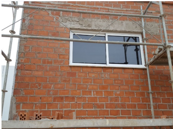
FOTO C – Vista general hoja principal de fachada con fábrica de ladrillo perforado de ½ pie de espesor y montaje carpintería exterior.
