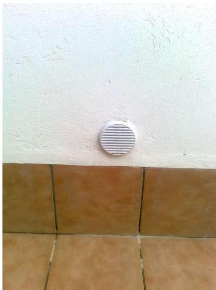
Foto M – Paso de tubería ventilación en cámara sanitaria
