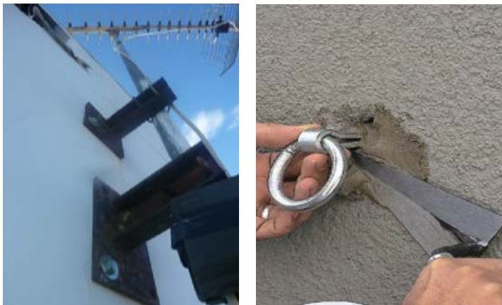
Foto N – Fijaciones de anclajes con tacos y de argollas en fachada
