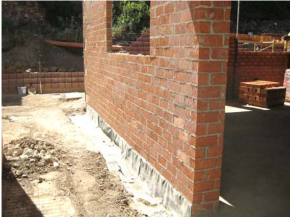
Foto D – Colocación barrera impermeable en arranque de fachada
