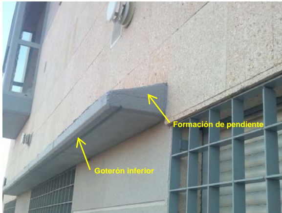
Foto G – Vista del encuentro de fachada con voladizo de hormigón
