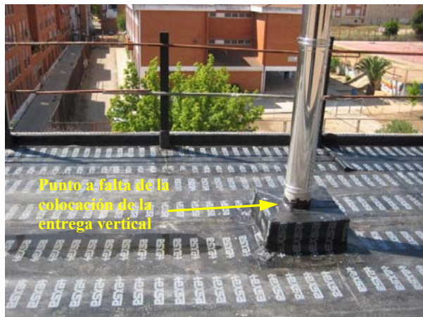
Foto M – Encuentro con el conducto de humos de una chimenea, mediante realización de un basamento previo perimetral de ladrillo que se impermeabiliza
