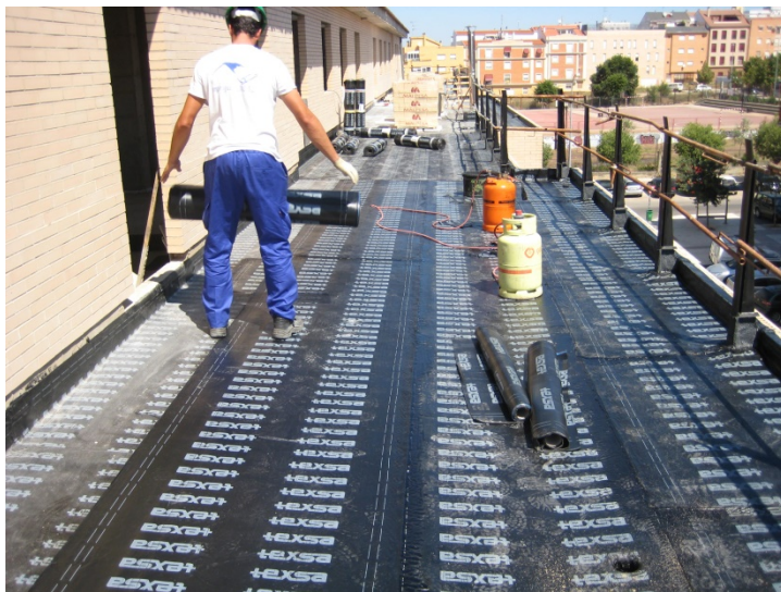
FOTO B – Puesta en obra de la impermeabilización de una cubierta.
