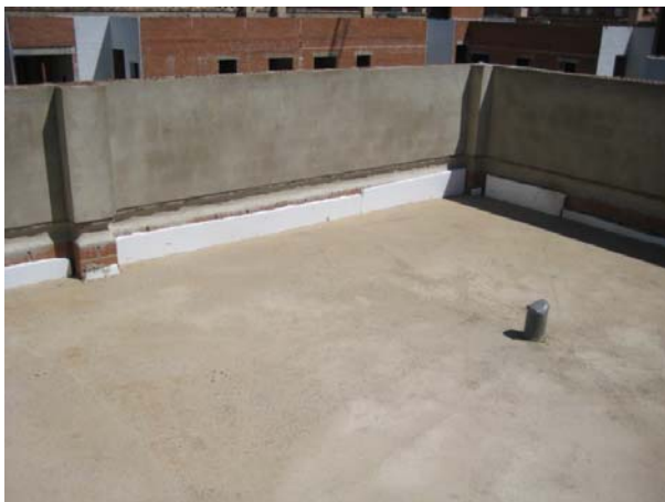
Foto F – Colocación de planchas de poliestireno expandido entre el peto y la formación de pendiente
