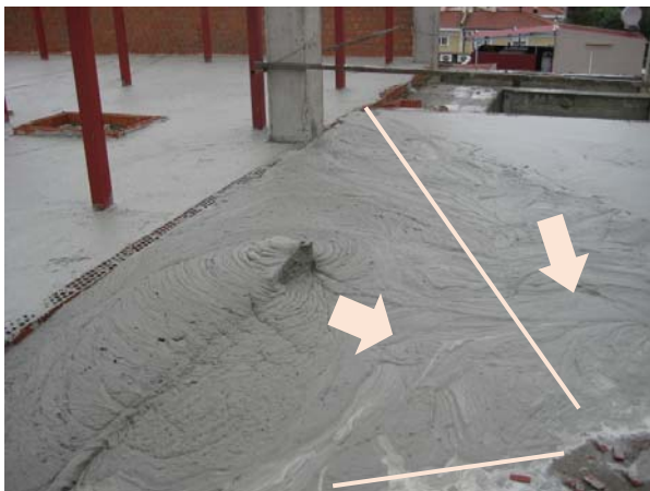
Foto C – Vertido de hormigón celular para realización de la formación de pendiente
