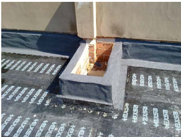
Foto H – Encuentro de una cubierta con un hueco para el paso de conductos
