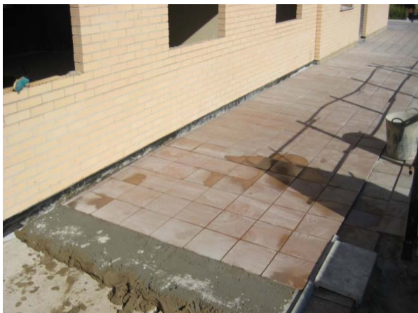
Foto N – Proceso de colocación de baldosas cerámicas en una cubierta
