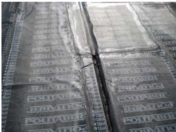
Foto L – Ejecución del encuentro de la impermeabilización con una junta de construcción-dilatación de cubierta, a falta de colocar la lámina superior en lira.
