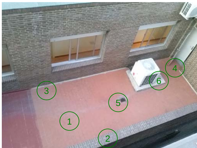
Foto A – Vista general de una cubierta con sus distintos elementos.
