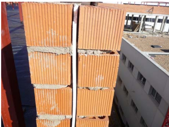
Foto D – Peto de ladrillo formado por dos medios pies de ladrillo perforado
