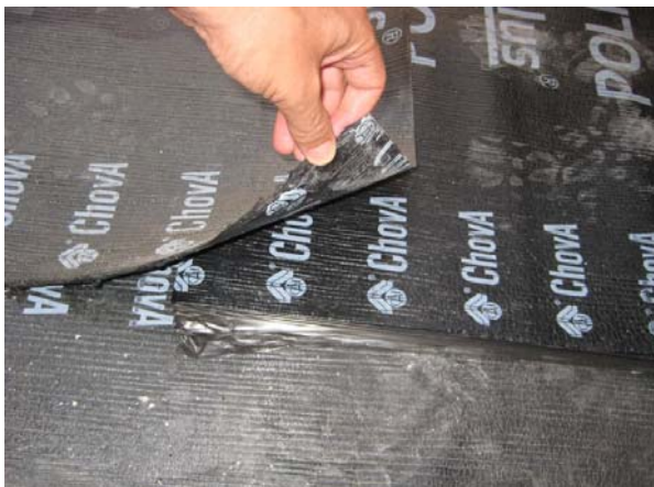
Foto G – Comprobación de que el ancho del solape entre láminas es el correcto
