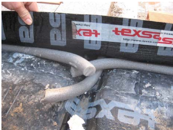
Foto K – Colocación de cilindro elástico en el interior de una junta de dilatación
