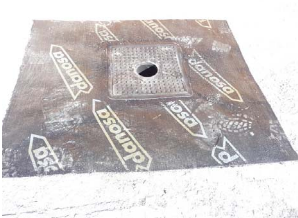
Foto J – Vista de la colocación de una cazoleta de EPDM y de la lámina de refuerzo previa a la lámina general
