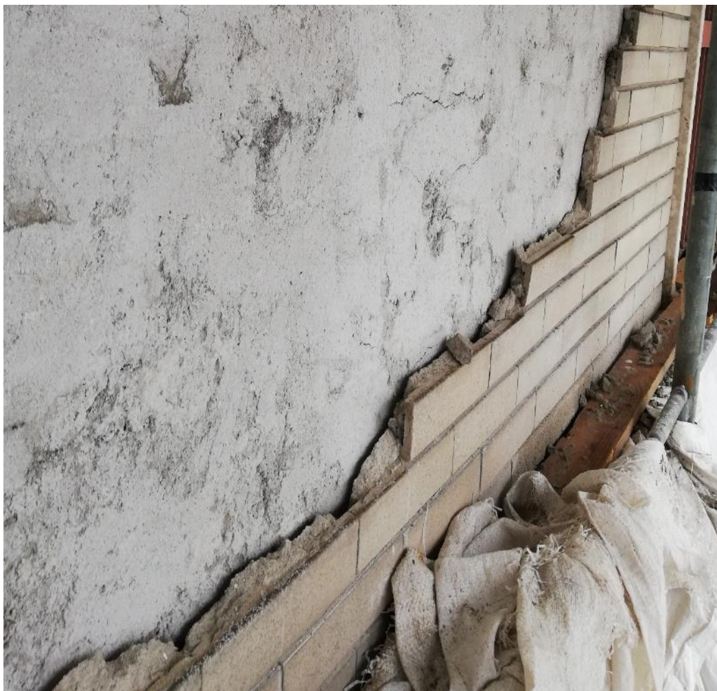
Enfoscados: Resistencia a tracción > 1 N/mm 2
