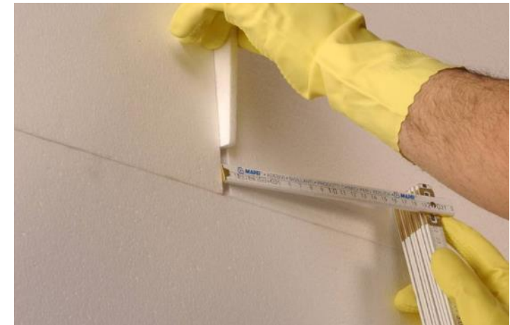
Eventuales espacios entre paneles deben cerrarse con retales del aislante y no con adhesivo.
