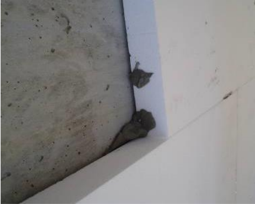
Quitar el adhesivo sobrante entre placas para evitar puentes térmicos.
