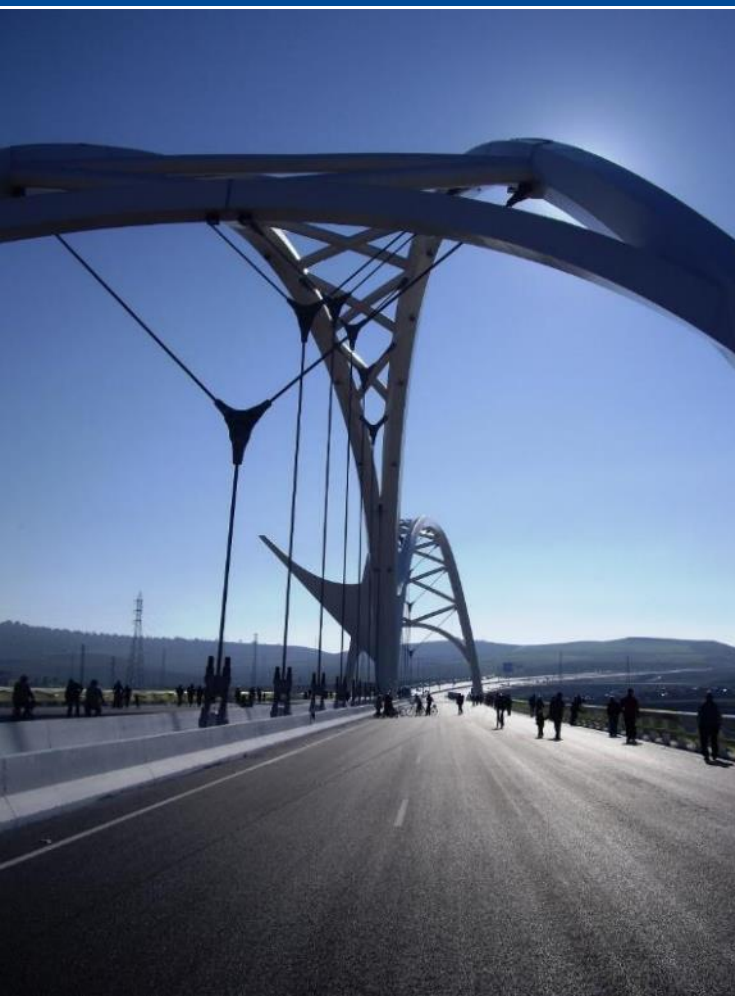
Impermeabilización Puente Abbas Ibn-Firnas (Córdoba)
