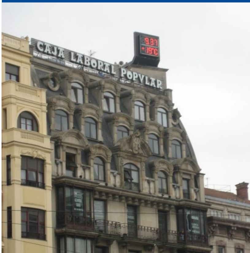
Edificio Caja Laboral (Bilbao)
