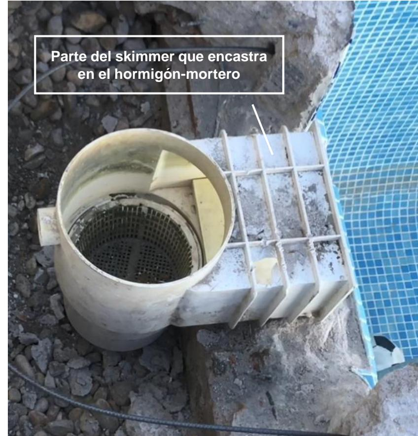
Parte del skimmer que encastra en el hormigón-mortero
