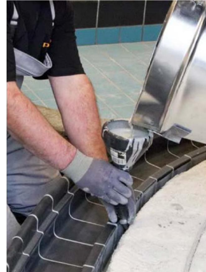
Filtraciones hacia las zonas adyacentes se pueden prevenir con un relleno con resina epoxi fluida altamente adherente e impermeable
