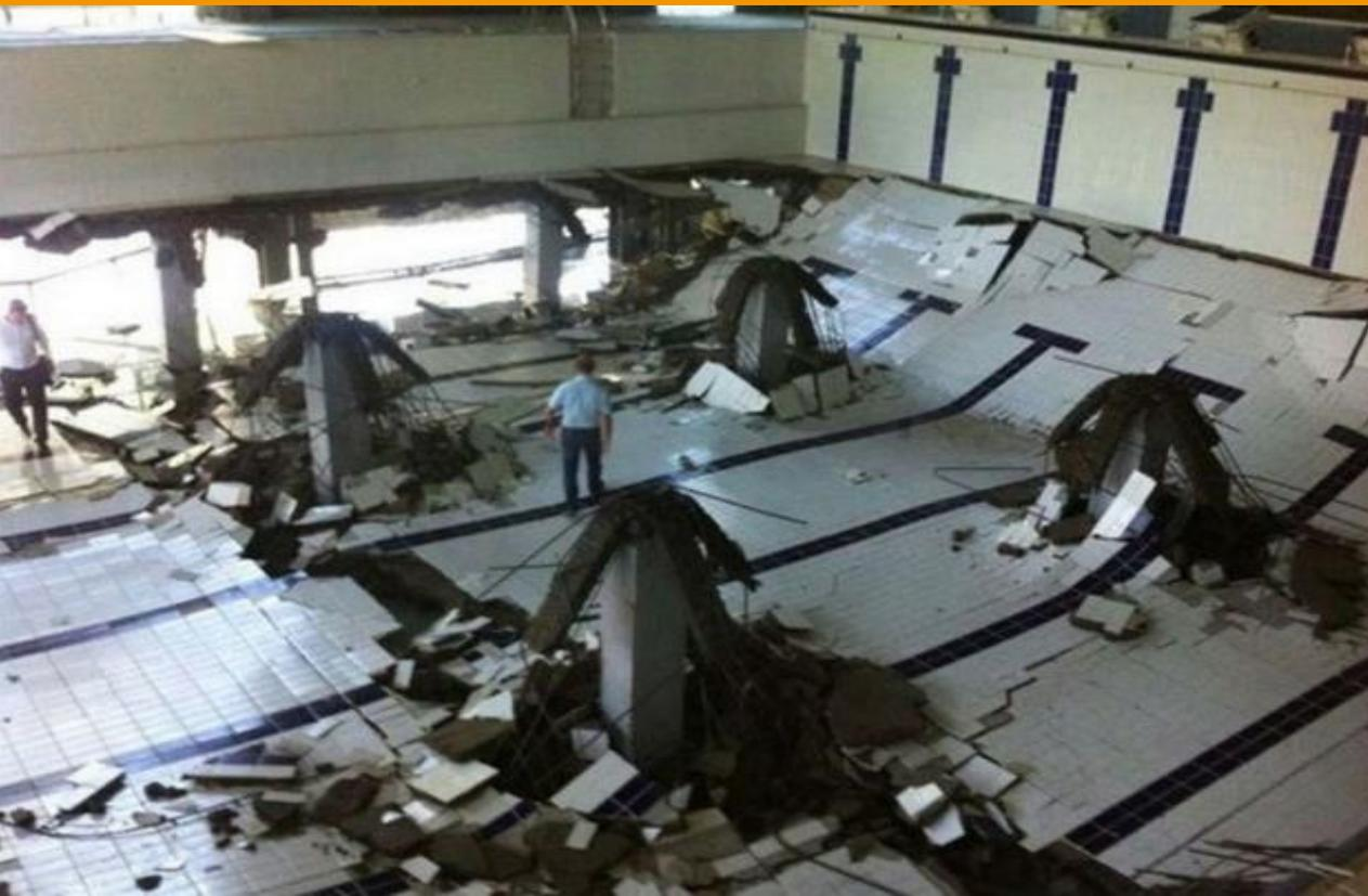
Los tratamientos de desinfección química suelen aportar cloruros que, en caso de fallo de la impermeabilización, llegan a las armaduras pudiendo provocar incluso el colapso del vaso
