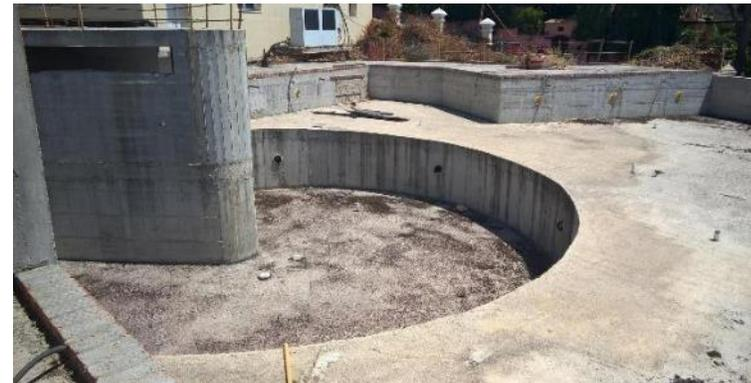
**Juntas y fisuras en piscinas, suelen tener movimiento y han de tratarse con productos elásticos**
