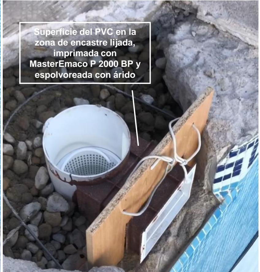
Superficie del PVC en la zona de encastre lijada, imprimada con MasterEmaco P 2000 BP y espolvoreada con árido
