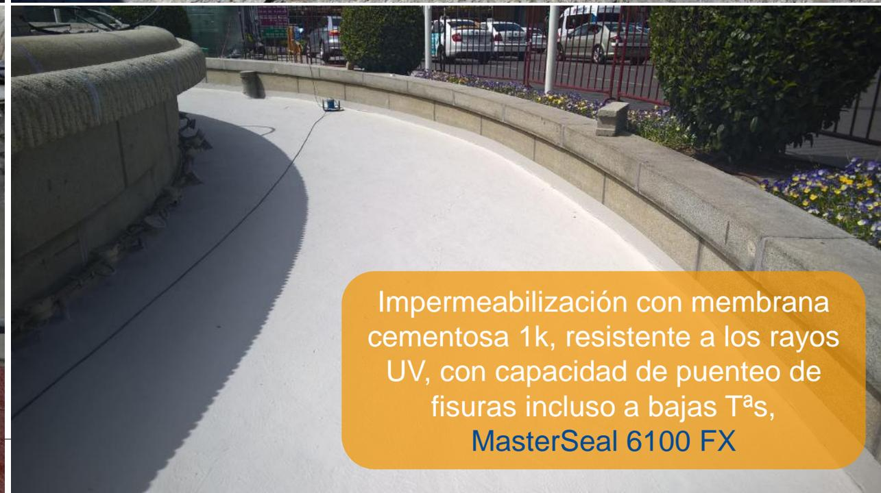
Impermeabilización con membrana cementosa 1k, resistente a los rayos UV, con capacidad de puenteo de fisuras incluso a bajas T<sup>as</sup>, **MasterSeal 6100 FX**
