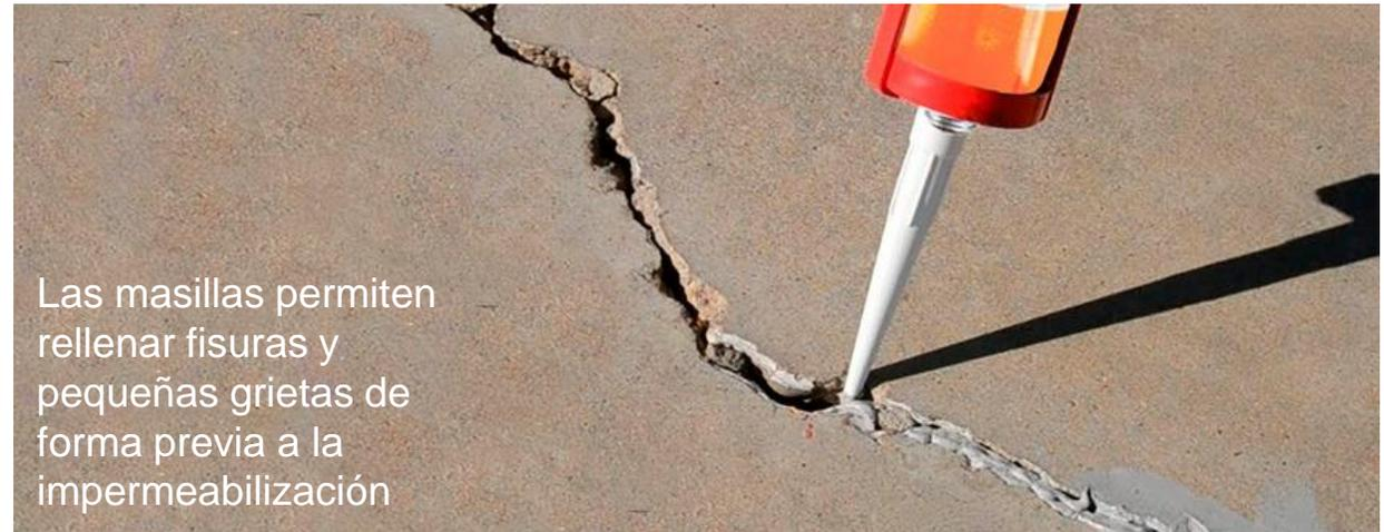
Las masillas permiten rellenar fisuras y pequeñas grietas de forma previa a la impermeabilización
