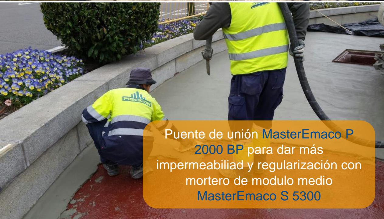
Puente de unión **MasterEmaco P 2000 BP** para dar más impermeabilidad y regularización con mortero de modulo medio **MasterEmaco S 5300**
