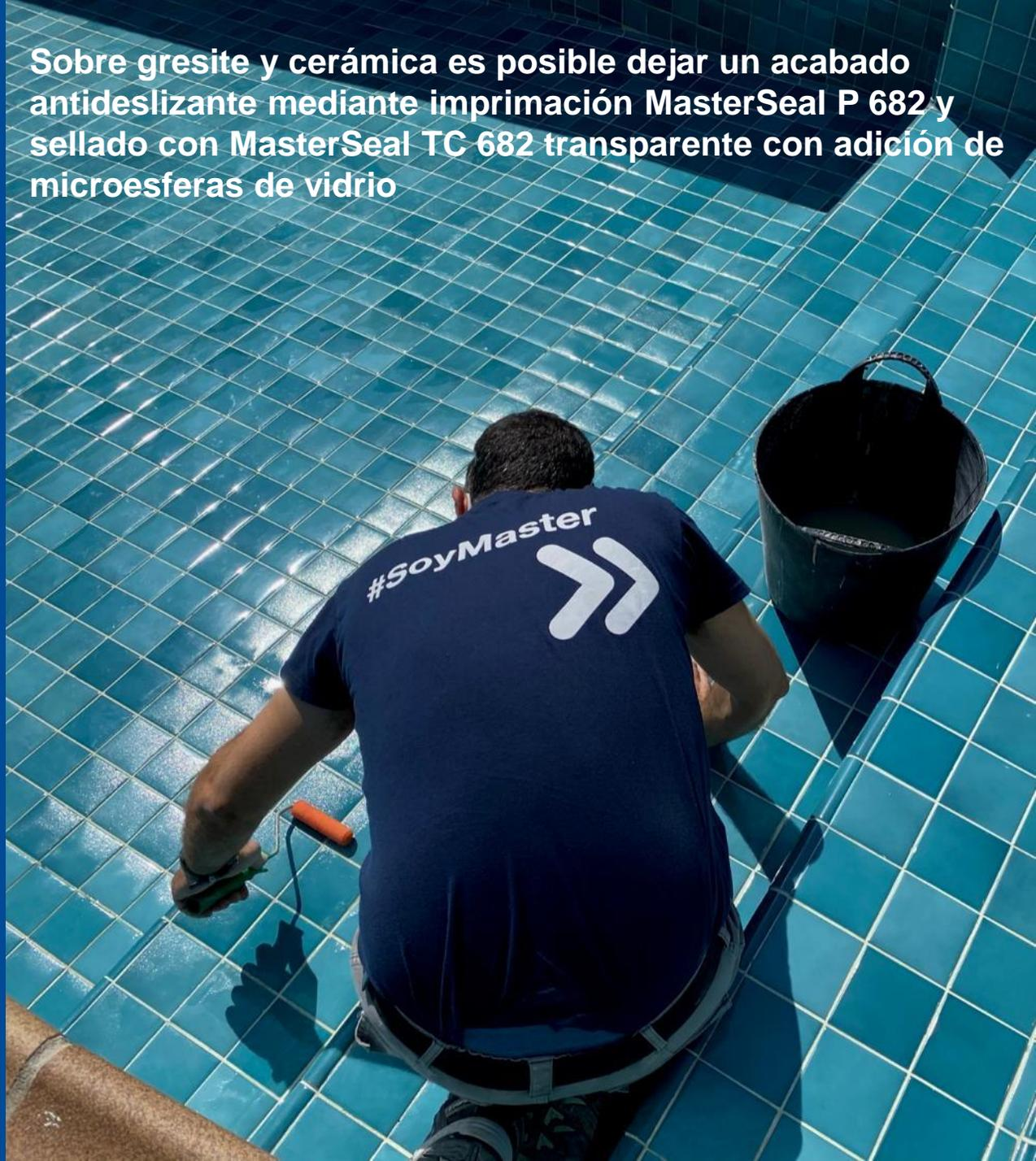
Sobre gresite y cerámica es posible dejar un acabado antideslizante mediante imprimación MasterSeal P 682 y sellado con MasterSeal TC 682 transparente con adición de microesferas de vidrio
