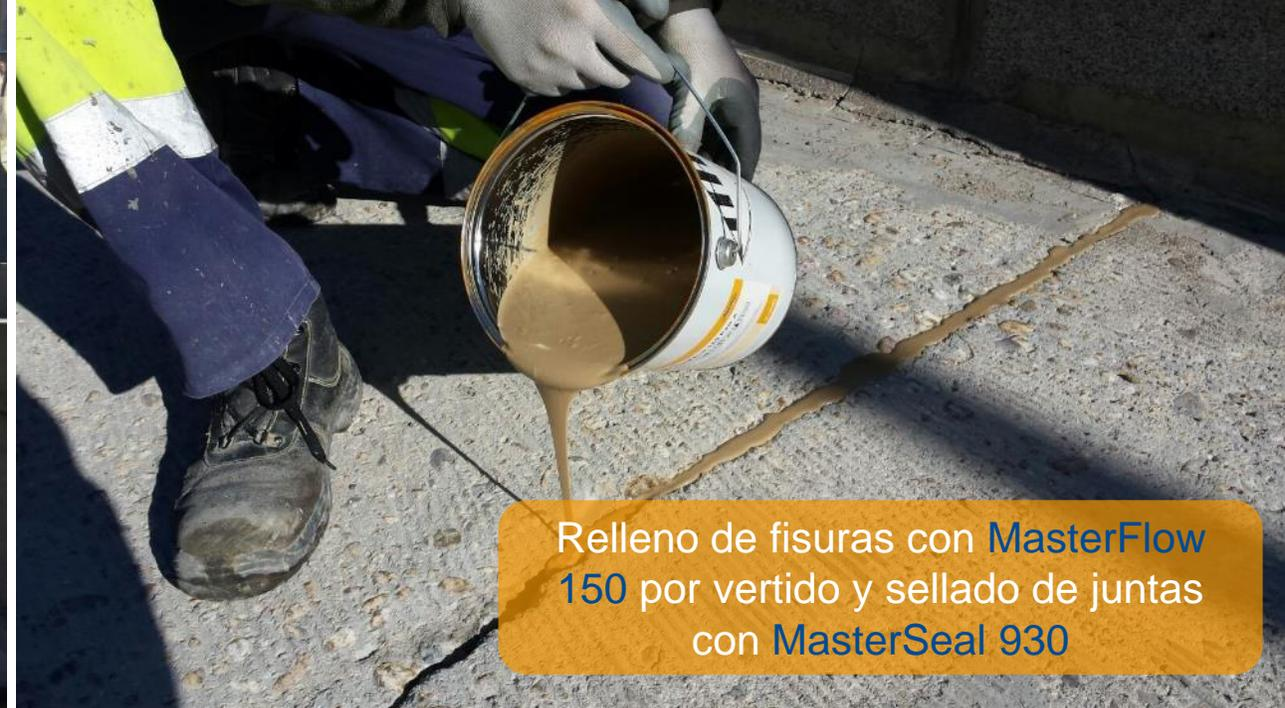
Relleno de fisuras con **MasterFlow 150** por vertido y sellado de juntas con **MasterSeal 930**
