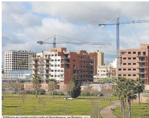
Edificios en construcción junto al Hornabeque, en Badajoz. HOY
