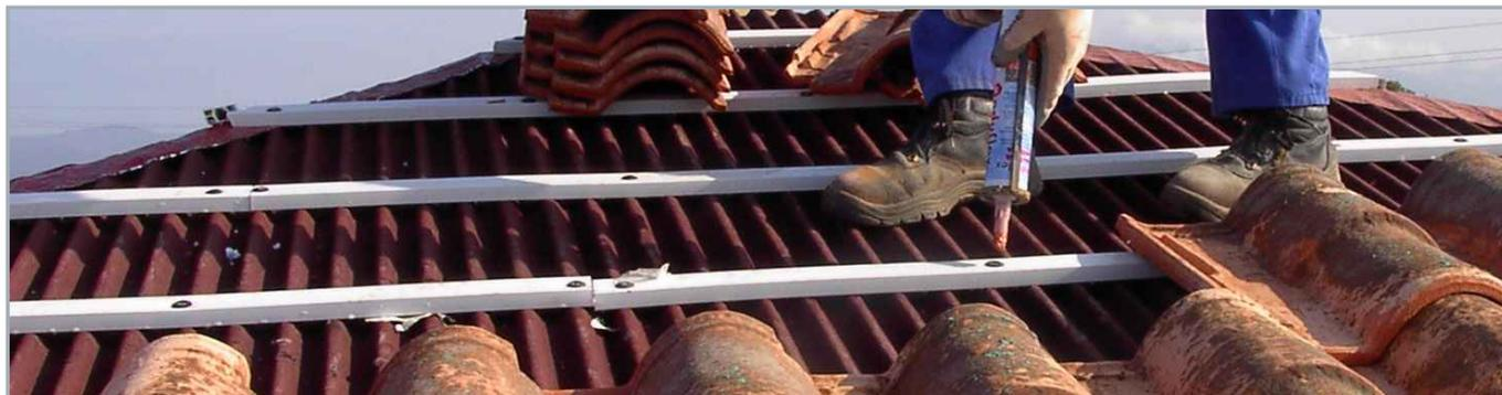
Onduline suministra un **listón plástico de fabricación propia**. El listón Onduline ofrece numerosas ventajas si lo comparamos con los tradicionales de madera o metálicos:
