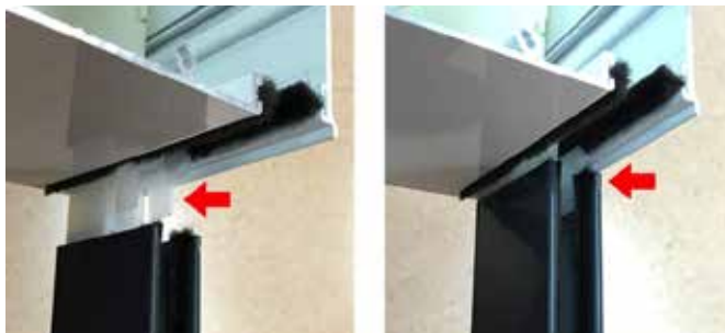
Figura 59. Unión ventana cajón
