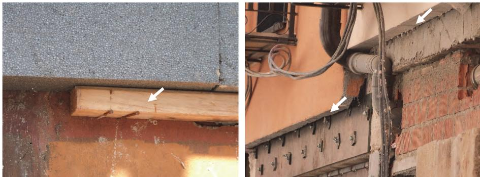
Imagen 44: Perfil de arranque inapropiado. Fuente: Marta Epelde. Imagen 45: Ausencia de perfil de arranque. Fuente: Marta Epelde.
