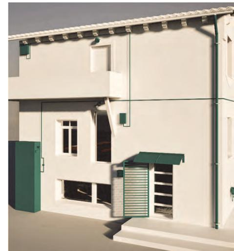
Ilustración 21: Análisis de instalaciones y elementos anclados a fachada que crean discontinuidad en la envolvente térmica (fachada lateral del edificio modelo).
