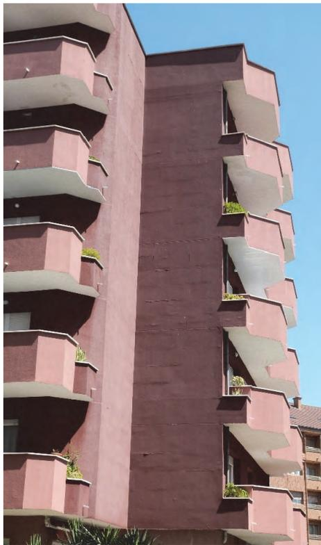
Imagen 38: Grietas y fisuras coincidente con las juntas de paneles aislantes. Fuente: Marta Epelde.
