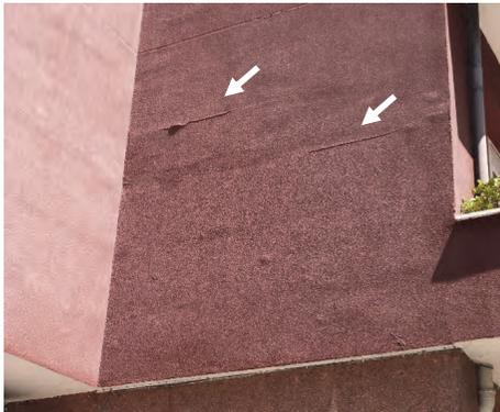
Imagen 39: Detalle de la fisuración en las juntas del SATE. Fuente: Marta Epelde.
