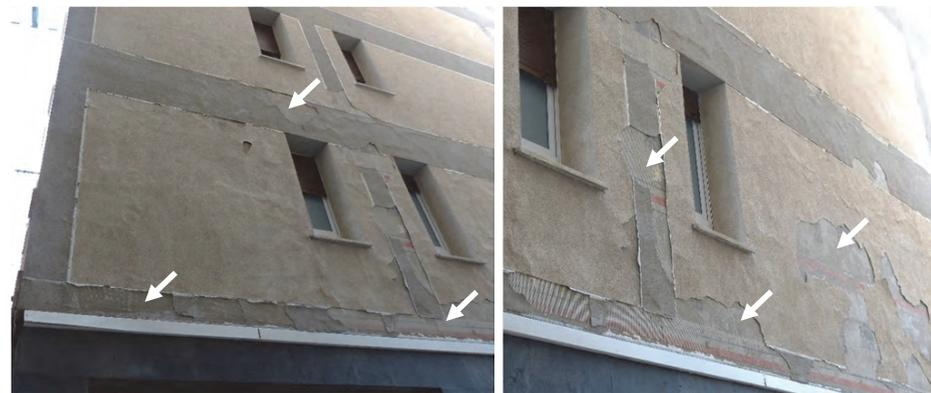
Imagen 61 e Imagen 62: SATE con deterioro generalizado que afecta a las capas de mortero de acabado, a la capa reforzada e incluso al aislamiento, que queda expuesto. Año 2024. Fuente: Marta Epelde.
