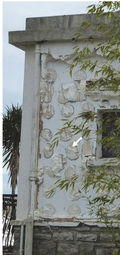
Imagen 58: Placas de aislamiento desprendidas (se observan las pellas de adhesivo pero no existe cordón perimetral de adhesivo). Fuente: Marta Epelde.
