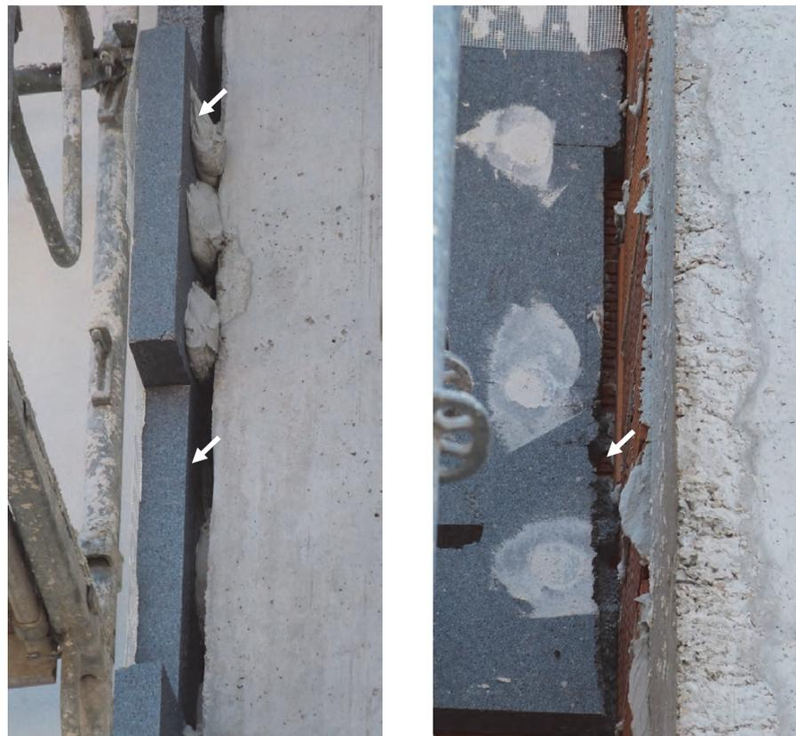
Imagen 55: Remate en esquina incorrecto: ausencia de encaje dentado y adhesivo sin cordón perimetral Fuente: Marta Epelde.
