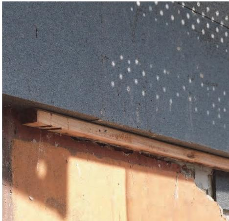
*Imagen 33: El error en el planteamiento del perfil de arranque provoca una ejecución inadecuada que afecta a todo el perímetro de arranque del SATE.*
