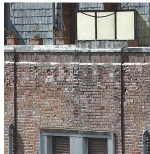
Imagen 12: Fachada de fábrica en estado pulverulento. Fuente: Marta Epelde.
