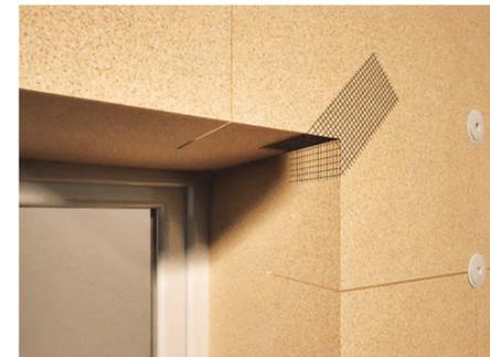
Ilustración 88: Refuerzo de vértices de hueco. Fuente: M. Epelde, A. Intxausti.
