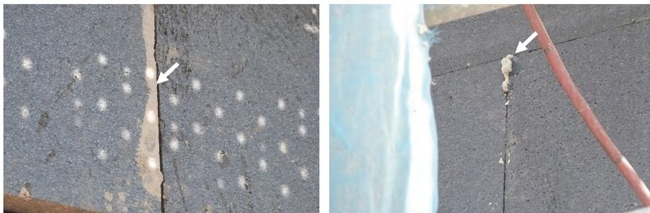
Imagen 51: Aislamiento con junta abierta y presencia de mortero.
