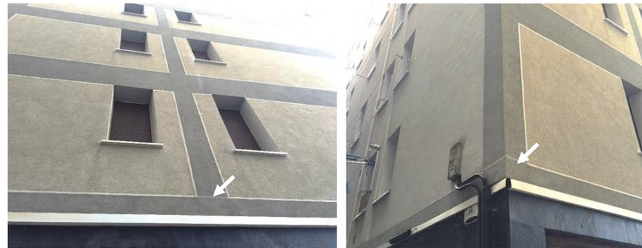
Imagen 59 e Imagen 60: SATE sin aparentes signos de patologías pero donde se aprecia la malla en algunos puntos, síntoma de posible error en la colocación de la malla y/o el espesor del mortero. Año 2015. Fuente: Marta Epelde.
