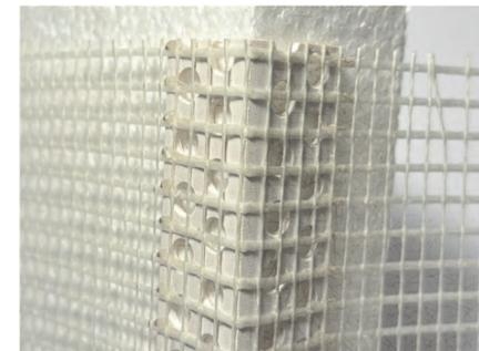
Imagen 20: Perfil cantonera con malla de armado. Fuente: Marta Epelde.
