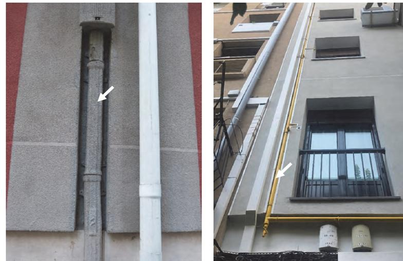
Imagen 47: Aislamiento interrumpido por canaleta metálica. Fuente: Marta Epelde.
