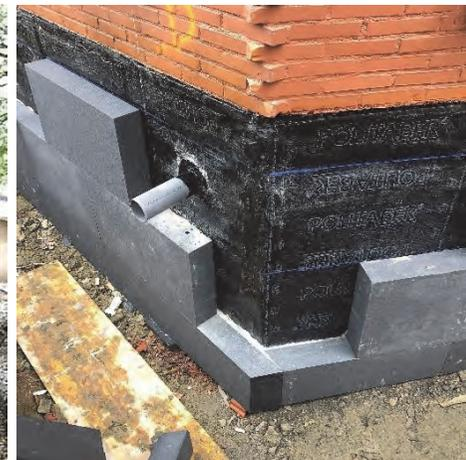
*Imagen 9: Pasatubos ejecutados en la envolvente térmica con una membrana líquida aplicada para su tratamiento hermético antes de la instalación del aislamiento. Fuente: Marta Epelde.*
