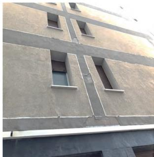
Imagen 10: Fachada existente con acabado desconchado. Fuente: Marta Epelde.
