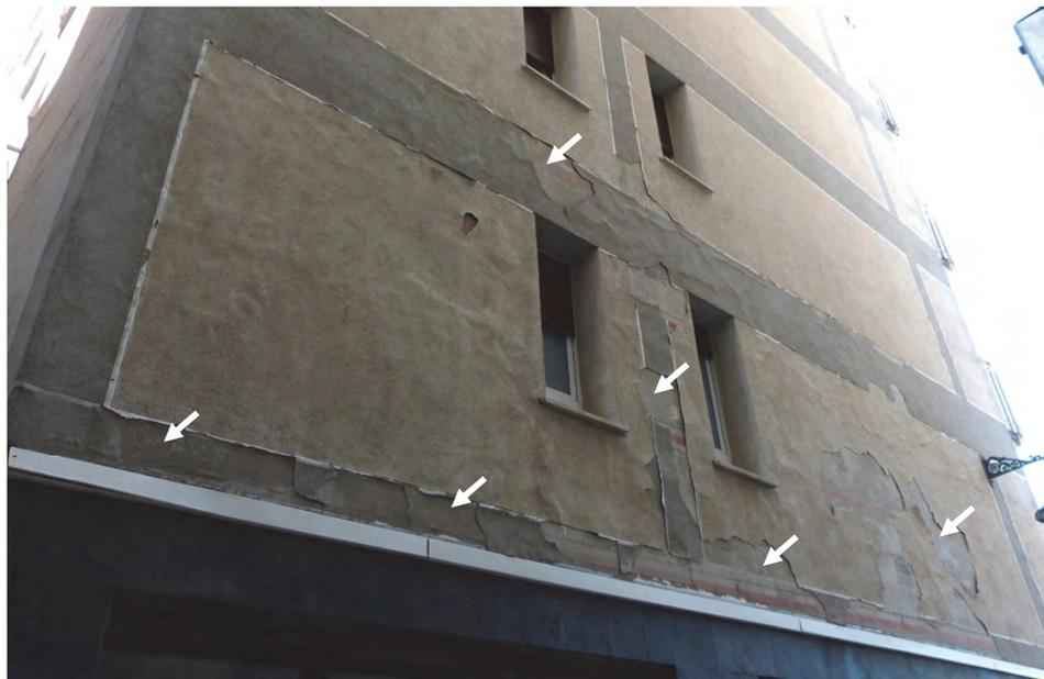
Imagen 34: Patología en las capa reforzada y capa base del aislamiento. Fuente: Marta Epelde.
