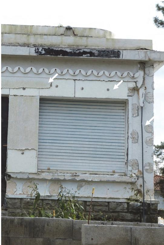
Imagen 57: SATE extremadamente deteriorado donde se observa la rotura de la malla, las escasas espigas y el desprendimiento del mortero y de las placas de aislamiento. Fuente: Marta Epelde.
