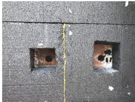
*Imagen 7: Ejemplo de incorrecto aislamiento de un SATE ya instalado donde se están realizando pasos de instalaciones a posteriori por falta de previsión. Fuente: Marta Epelde.*
