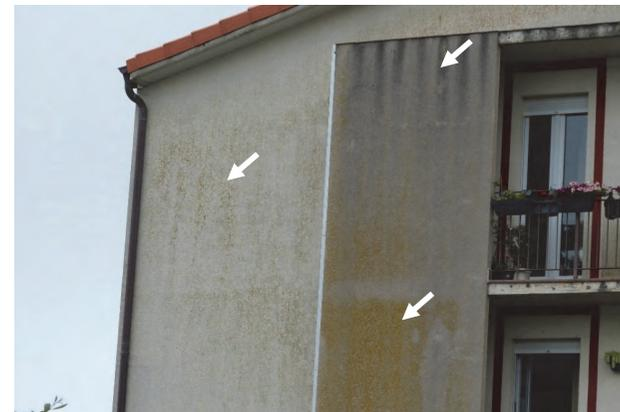
Imagen 43: Ensuciamiento y contaminación microbiológica en fachada norte del SATE. Fuente: Marta Epelde.
