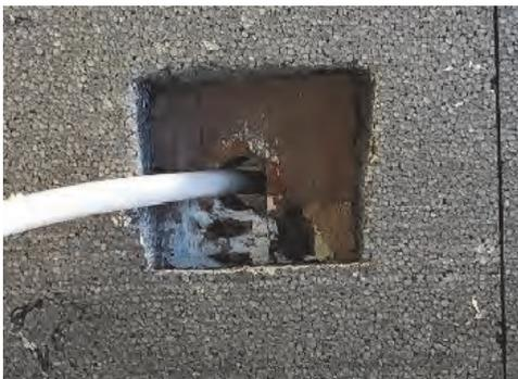
*Imagen 6: Ejemplo de incorrecto aislamiento de un SATE ya instalado que ha sido recortado para el paso de una instalación no planificada. Fuente: Marta Epelde.*
