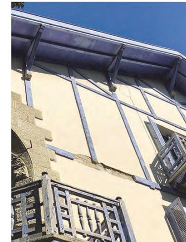
Imagen 13: Franjas de mortero decorativas en mal estado en edificio tipo nevasco (País Vasco). Fuente: Marta Epelde.
