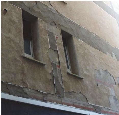
*Imagen 32: El error generalizado en el planteamiento de la capa base provoca una patología que afecta a toda la superficie del sistema.*
